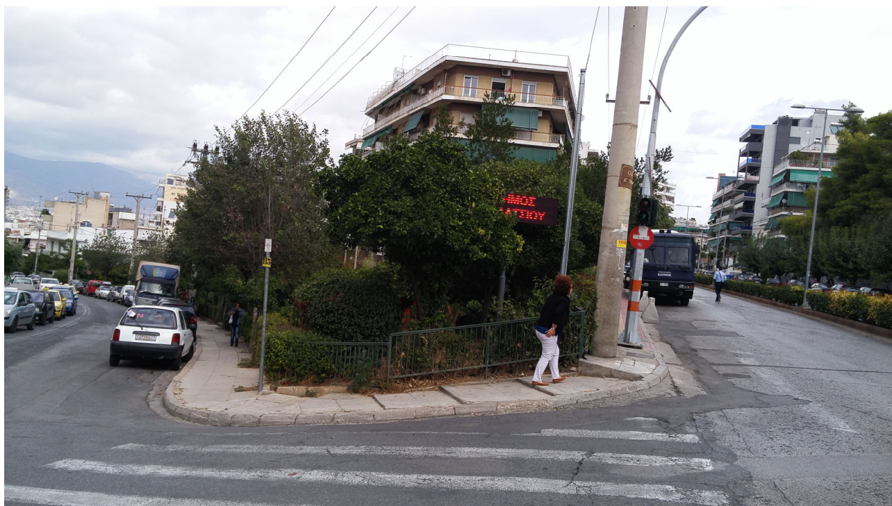
Φ1. Άποψη χώρου κεντρικού φρέατος κατασκευής σταθμού Ελικώνος (από διαστ. Αγίας Γλυκερίας και Πάρνηθος)
