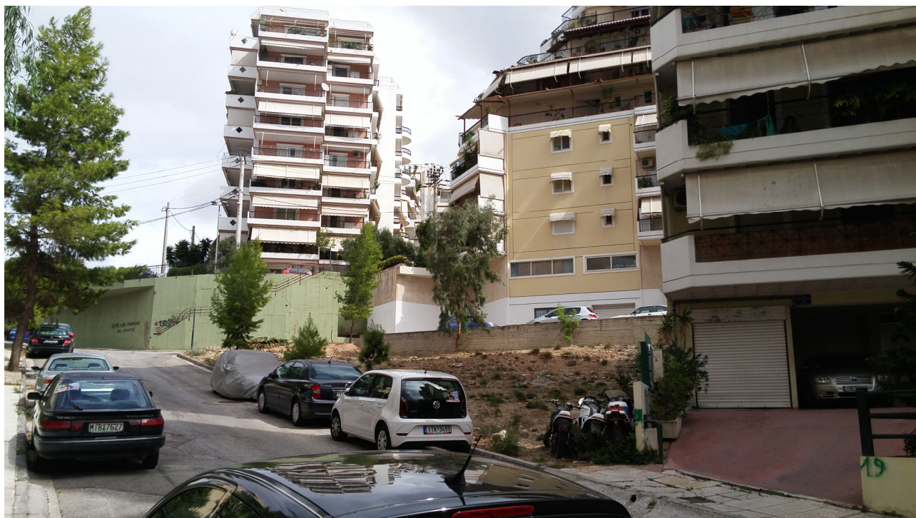
Φ5. Άποψη χώρου 2ου φρέατος σταθμού Ελικώνος επί της οδού Ζήνωνος
