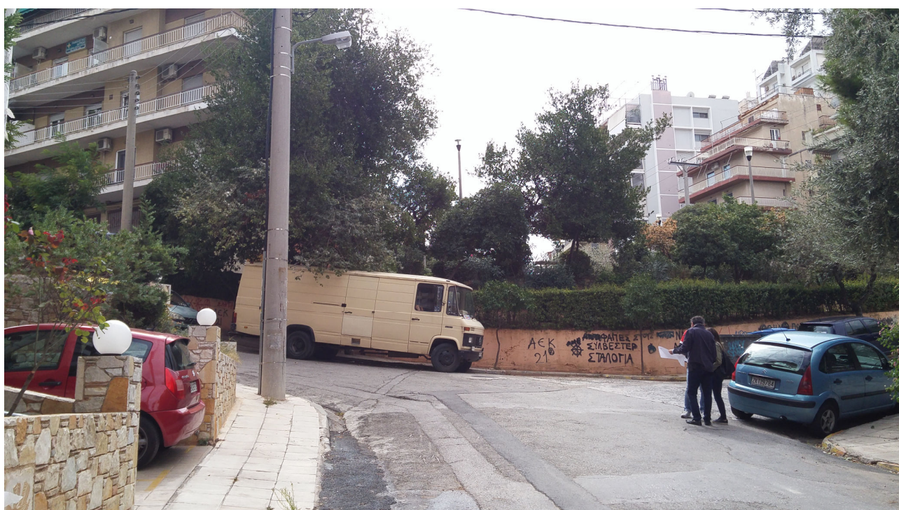
Φ2. Άποψη χώρου κεντρικού φρέατος κατασκευής σταθμού Ελικώνος (από οδό Ιθάκης)
